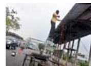
Perbaikan dan Perawatan Halte Bus Transjakarta
